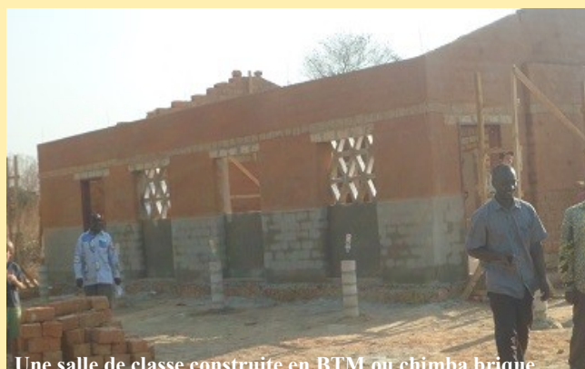
Une salle de classe construite en BTM ou chimba brique améliorée au village Chem chem du côté de la Ruashi
